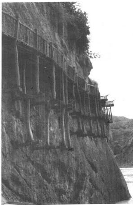
朝天峡秦栈依崖三梁中柱式栈道
